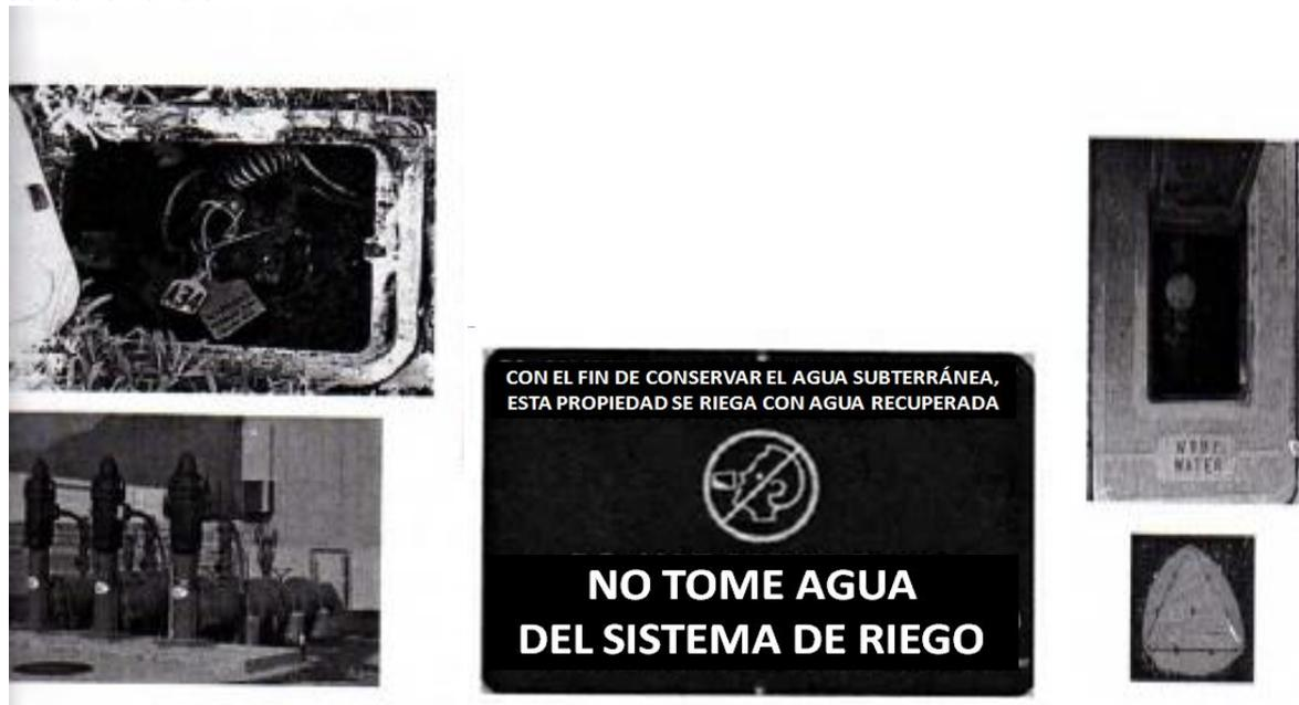
**Fig. III-2.- Tuberías de color morado y letreros de advertencia para el público usados en los sistemas de agua recuperada**
